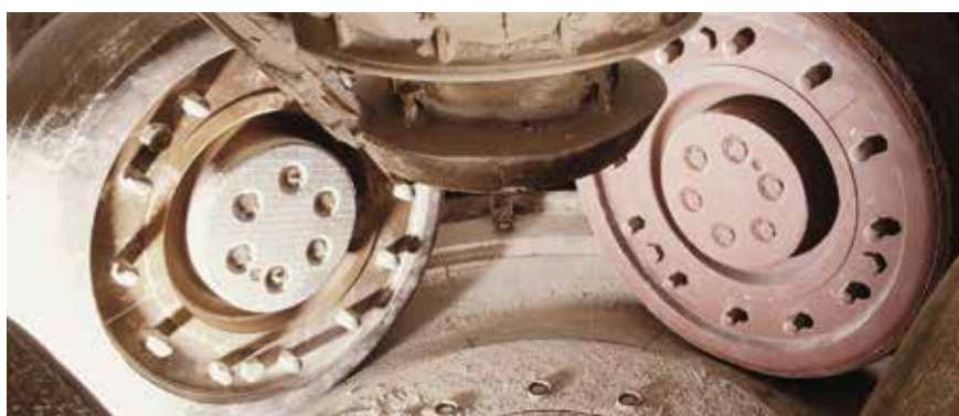
Размалывающие валки вертикальной мельницы (переработка цемента)
